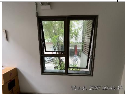
รูปที่ ผ7.42 ช่องระบายอากาศบริเวณห้องโถงหน้าลิฟต์ดับเพลิง
